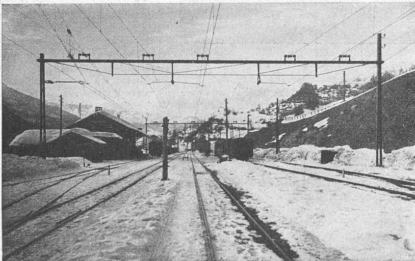
Abb. 12. Eiserne Tragkonstruktion über fünf Geleise im Bahnhof Filisur.
