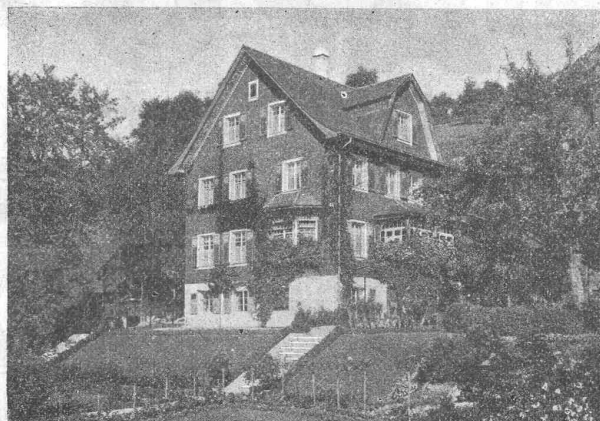
Eternit-Wohnhaus in Zug.
