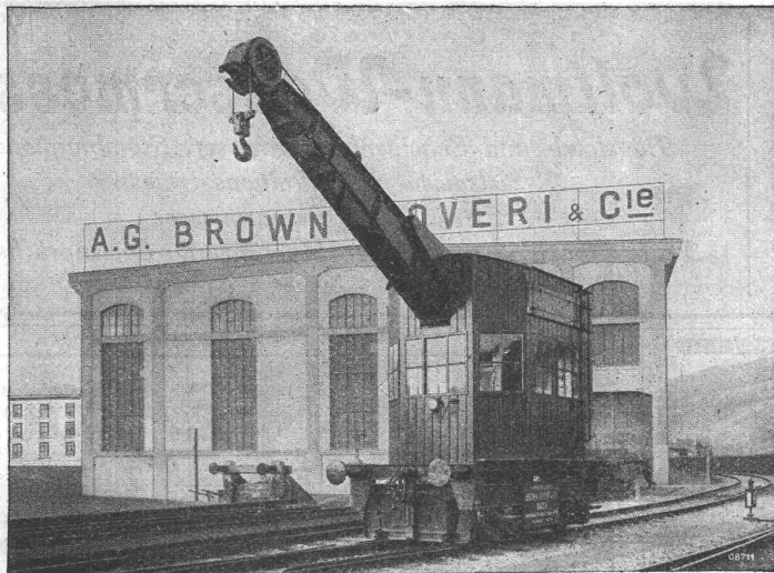
Lokomotiv-Drehkran mit Akkumulatorenbetrieb für den Werkstätten- und Verladedienst.
