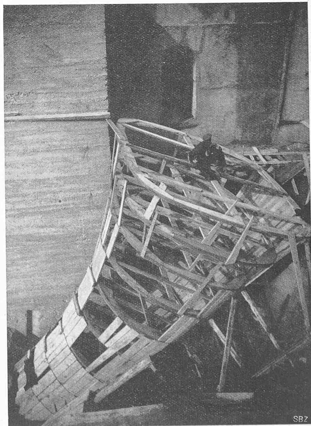
Abb. 23. Schalung zur Betonierung eines Einlauftrichters der Rohrleitung.
