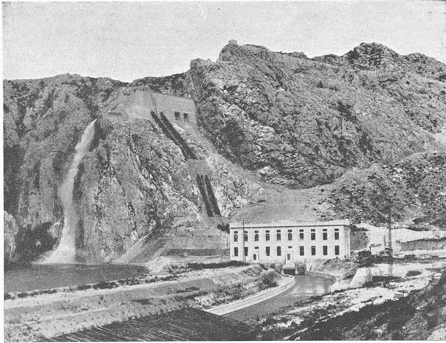
Abb. 24. Gesamtbild von Wasserschloss, Druckleitung, Maschinenhaus und Unterwasser-Kanal.
