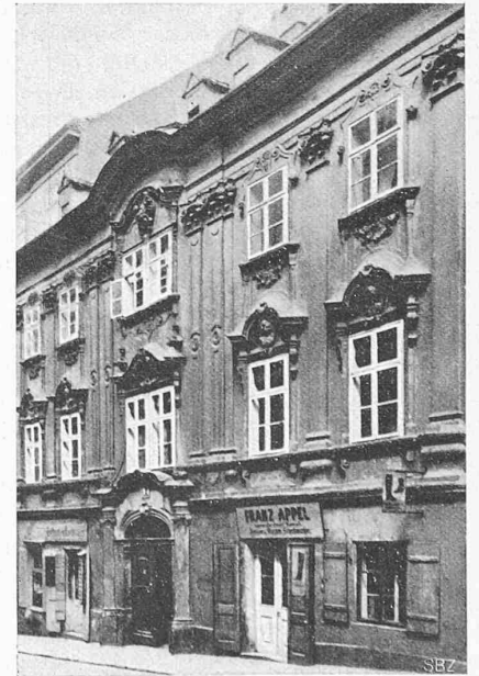
Abb. 3. Wohnhaus am Ulrichsplatz, Wien.
