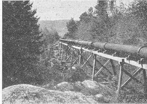
Abb. 2. Pumpwasserleitung der Zellulosefabrik Moelven. Spiralumschnürte hölzerne Muffenröhren, Durchmesser 480 mm.
