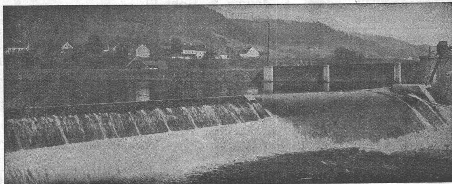
Hydraul. Dachwehr des Elektrizitätswerkes Bruck a/ Mur.
