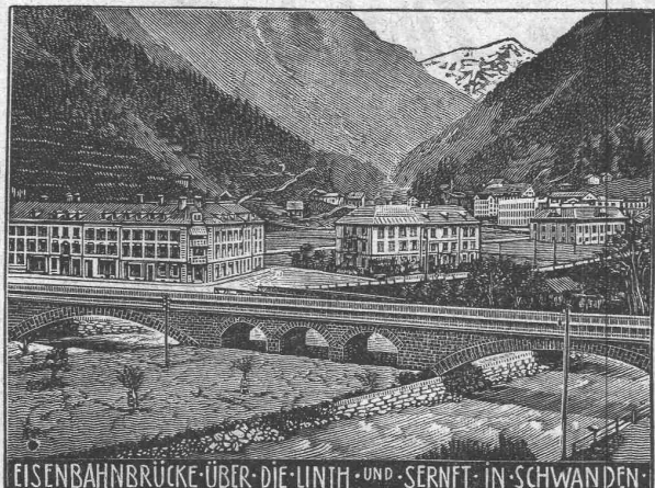
EISENBAHNBRÜCKE ÜBER DIE LINTH UND SERNFT IN SCHWANDEN
