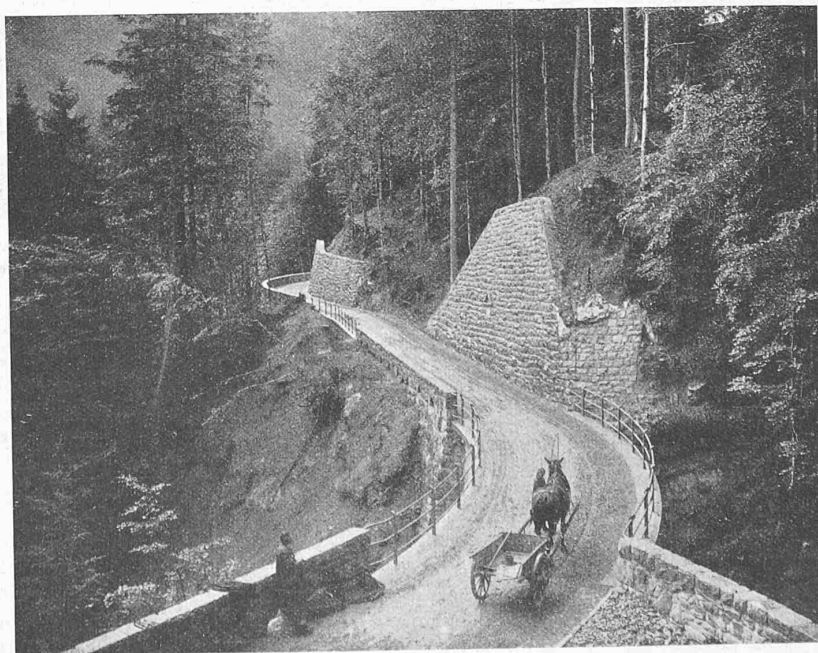
Abb. 13. Fertige Strasse bei Km. 1,35 bis 1,47 (vergl. oben Abb. 10 und 11).
