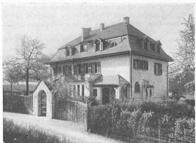
Abb. 2. Nördliche Zufahrt zum Hause „Im Guggi“.
