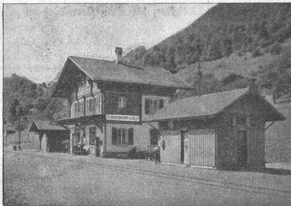
Station der Brienzerseebahn. Eternit-Doppeldach, kupferbraun.
