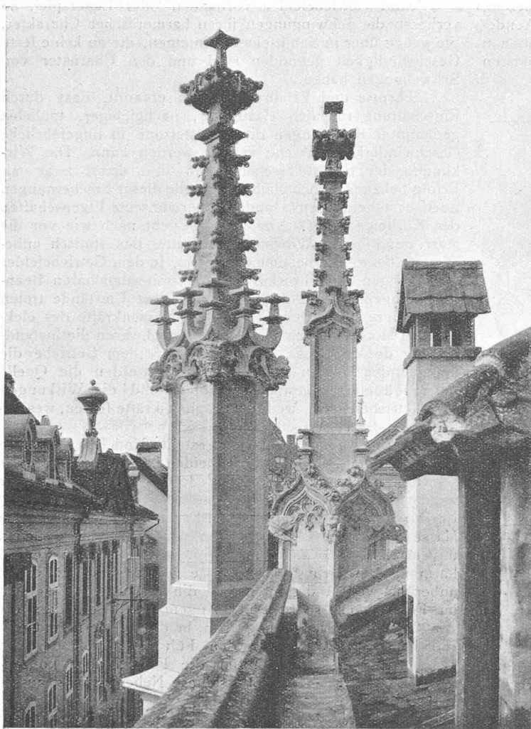
Abb. 4. Neue Fialen an der Südwestecke des Berner Münsters.
