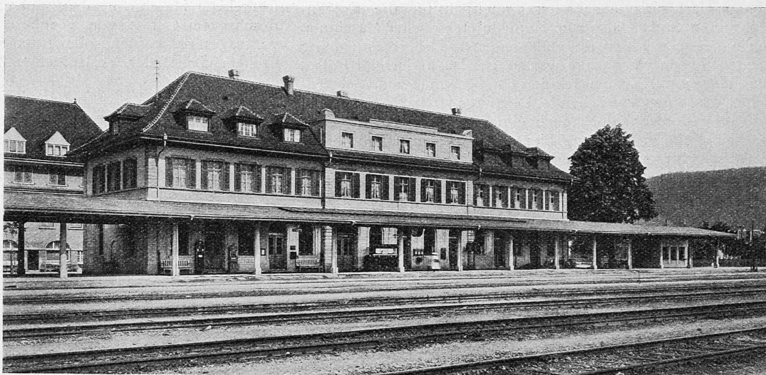
Abb. 7. Gesamtbild des durch Arch. Alb. Froelich umgebauten Bahnhofs Brugg von der Bahnseite.
