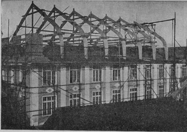
Stockwerksaufbau einer Fabrik nach Hetzer'scher Bauart.
