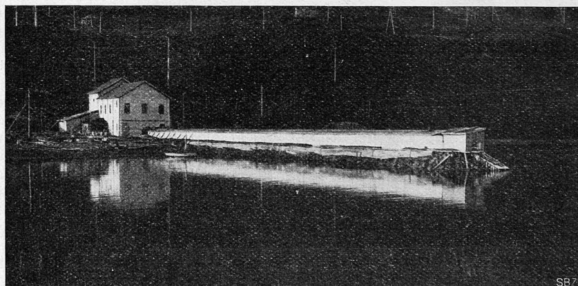
Abb. 4. Die Zentrale auf Spitzbergen mit der überdeckten Kühlwasser-Leitung.
