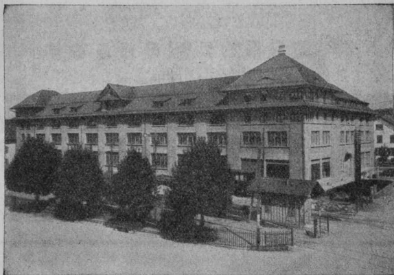
FABRIK IN USTER Bedachung in Eternit-Doppeldeckung, kupferbraun
