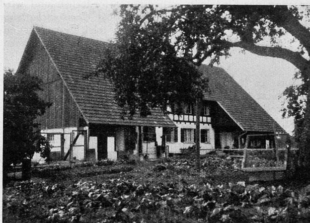
Abb. 12. Doppelwohnhaus Typ B, Rückansicht.
