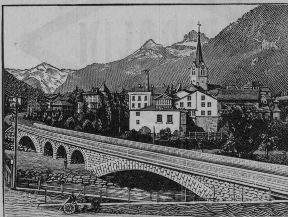
Eisenbahnbrücke ü. d. beiden Lintharme i. Schwanden
