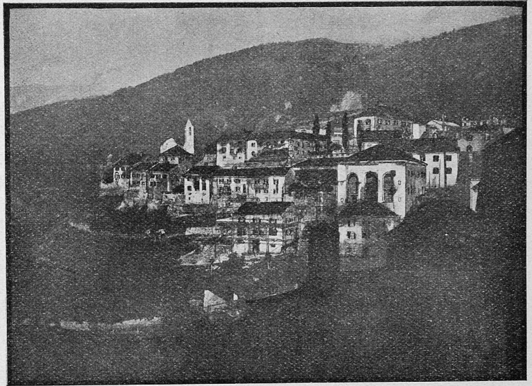
Gesamtbild aus Südost, Uebermalung untenstehender Photographie.
