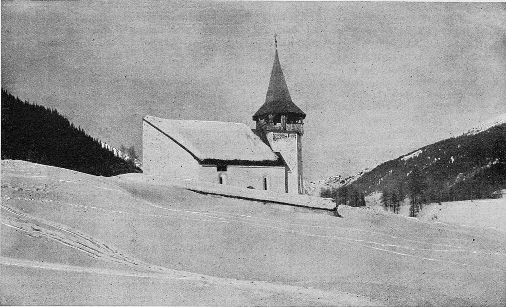
Abb. 1. Davos-Frauenkirch, U. L. Frau (erbaut 1603, bergseitige Rückwand als Lawenbrecher).
