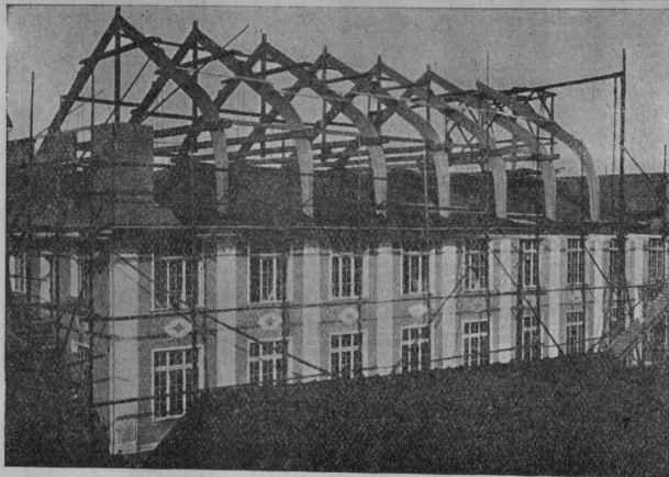
Stockwerksaufbau einer Fabrik nach Hetzer'scher Bauart.
