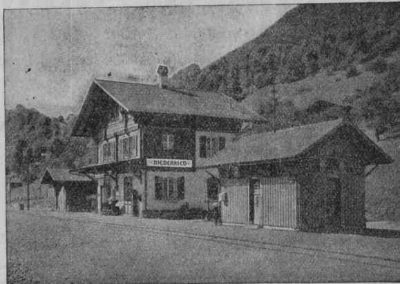
Station der Brienerseebah Eternit-Doppeldach, kupferbraun.
