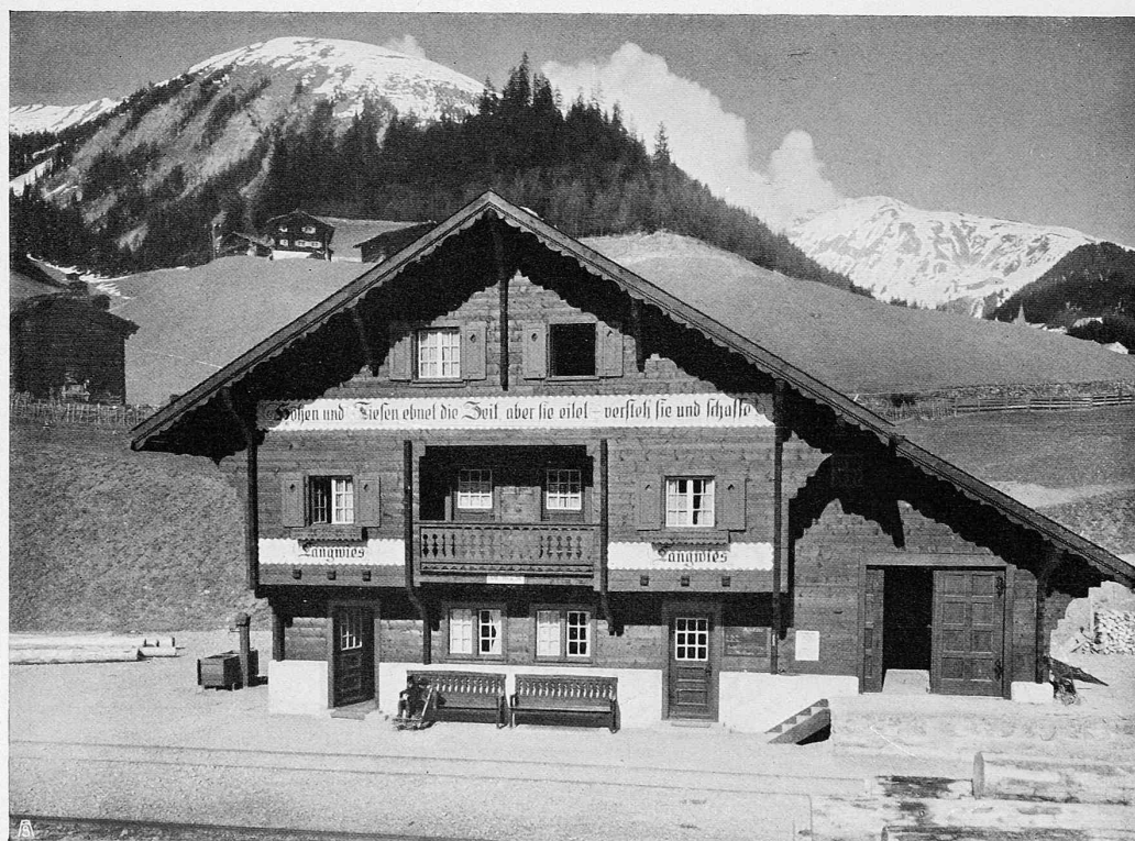
STATIONSGEBÄUDE LANGWIES DER CHUR-AROSA-BAHN
