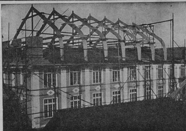
Stockwerksaufbau einer Fabrik nach Hetzer'scher Bauart.
