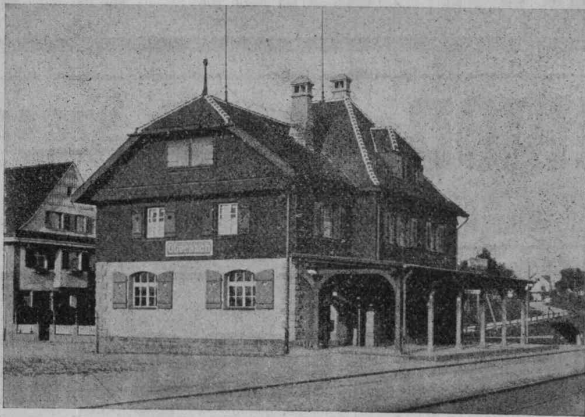
Stationsgebäude in Oberaach. Aeusserer Wandverkleidung: Eternit-Geschlaufte Deckung, kupferbraun.
