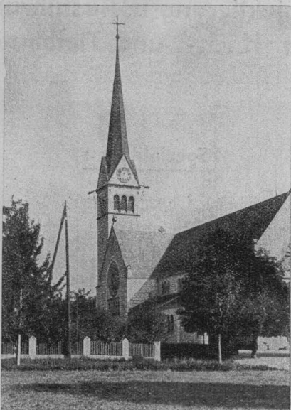
Kirchturm in Wettingen. Bedachung: Eternit-Doppeldach, kupferbraun.
