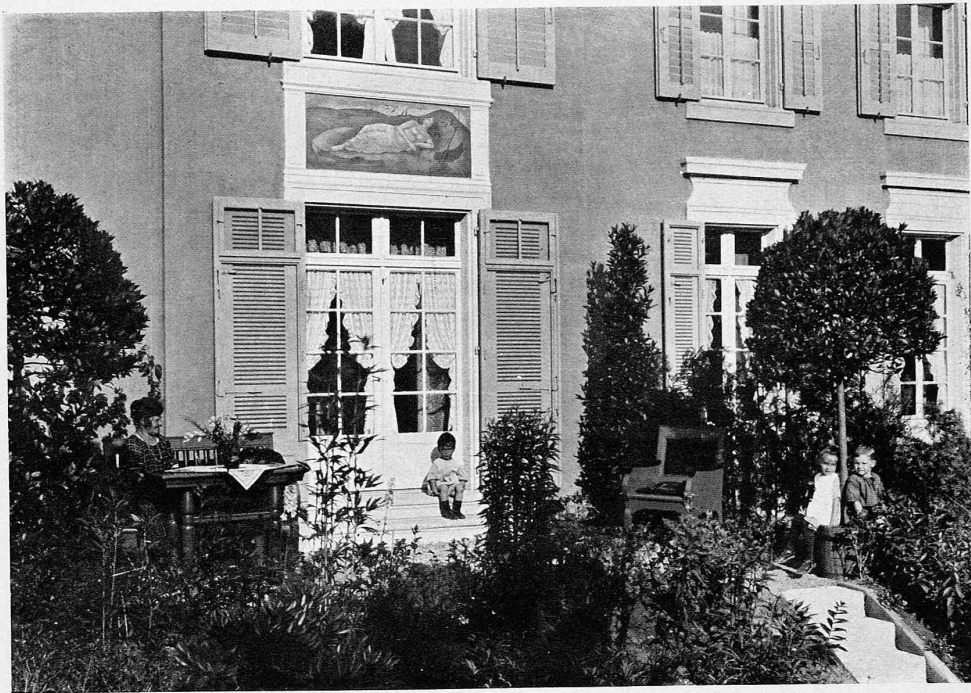
EINFAMILIENHÄUSER REHALP DER ARCH. KÜNDIG & OETIKER, ZÜRICH
