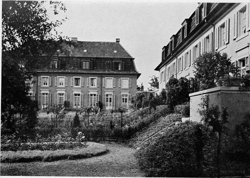
SÜDFRONT DES NÖRDLICHEN BAUBLOCKS, RECHTS DER ÖSTLICHE BLOCK UNTEN BLICK IN DIE NORDÖSTLICHE GARTENECKE
