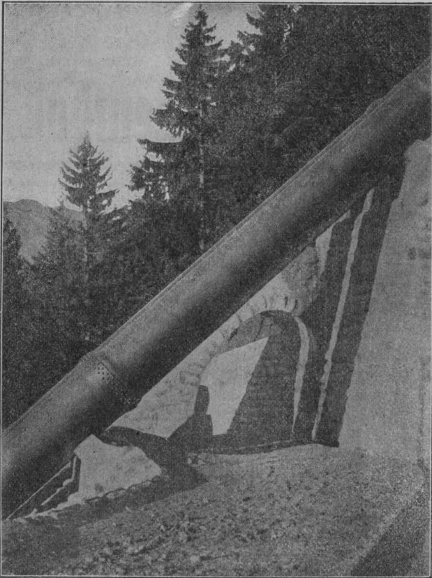
Turbinenleitung des Ritomwerkes der S B B mit Nietmuffenverbindung, geliefert von Thyssen & Co. A.-G., Abteilung Stahl- und Walzwerke, Mülheim a. d. Ruhr, durch die Firma Escher Wyss & Co., Zürich.
