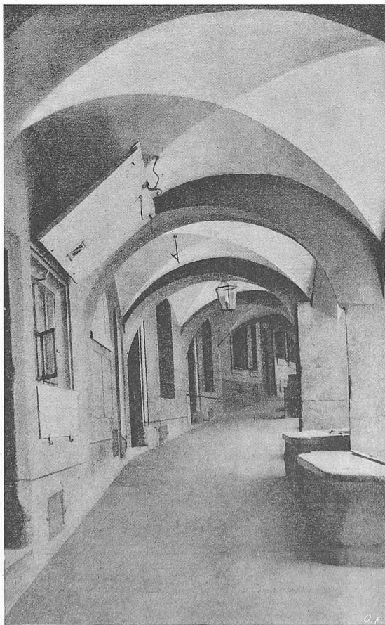
Lauben an der untern Junkerengasse (vergl. Seite 143) mit den mittelalterlichen Fensterverschlüssen durch Klapppläden.
