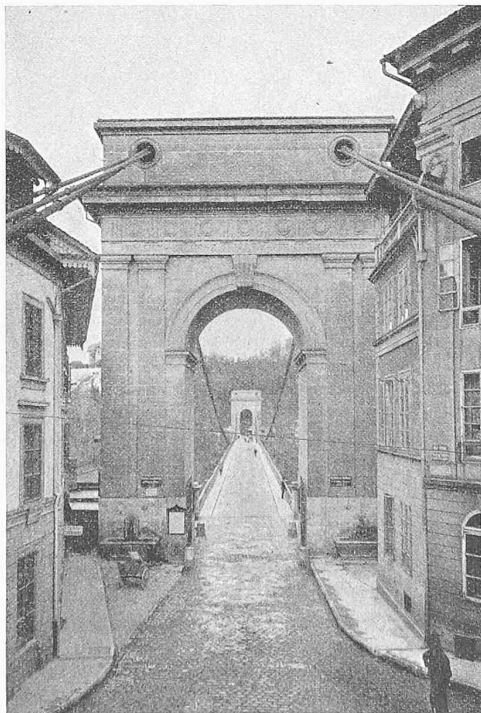
Abb. 2. Durchblick durch das stadtseitige Brücken-Portal.
