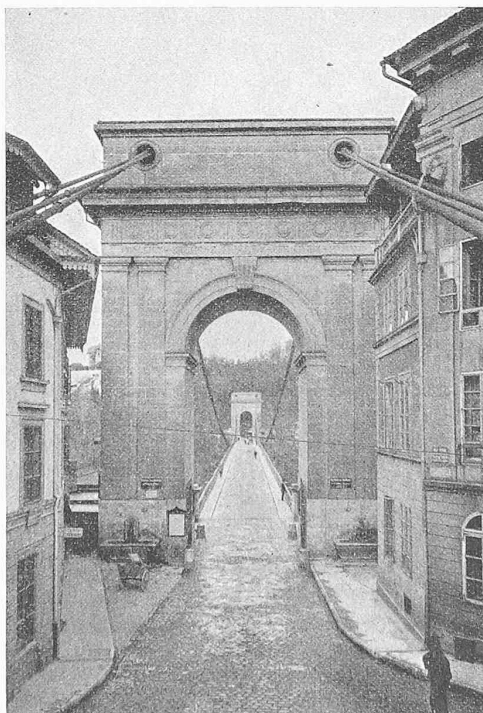
Abb. 2. Durchblick durch das stadtseitige Brücken-Portal.
