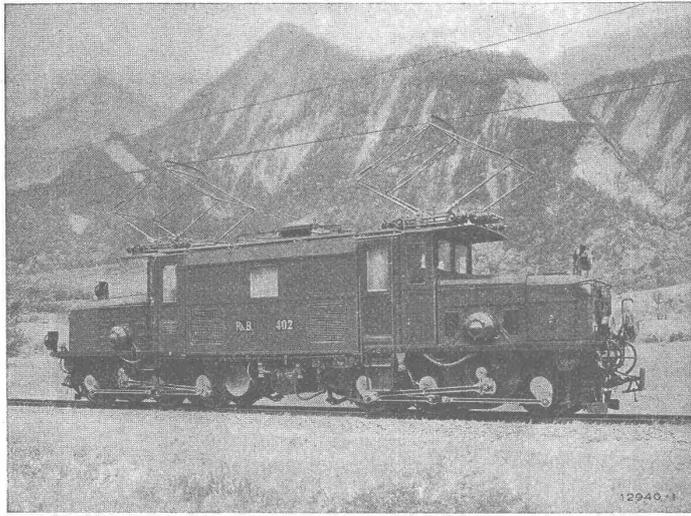
Einphasenstrom-Lokomotive, Type C-C für die Rhätische Bahn
