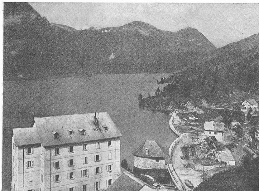
Abb. 12. Staumauer und Schieberhaus der Wasserfassung am Ritom-See.
