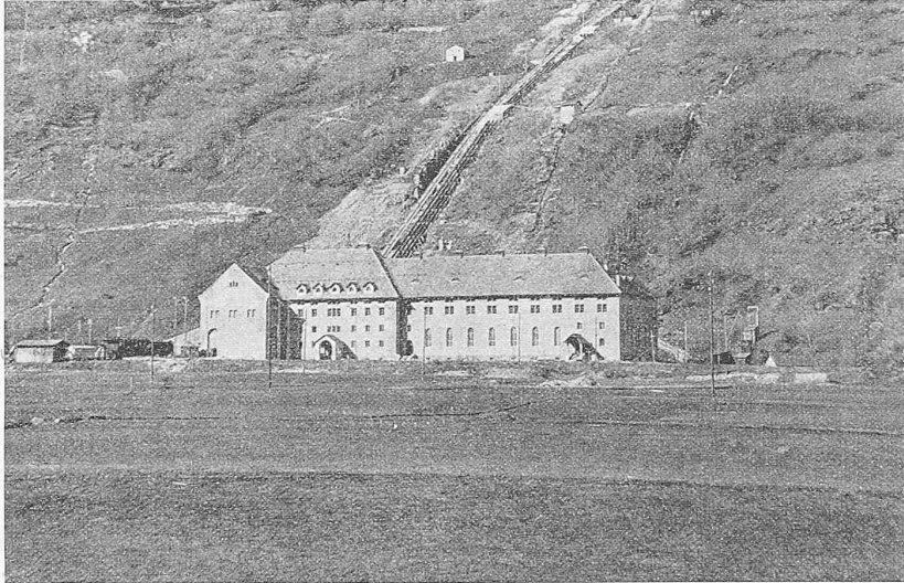
Abb. 35. Das Maschinenhaus des Kraftwerkes Ritom bei Piotta.
