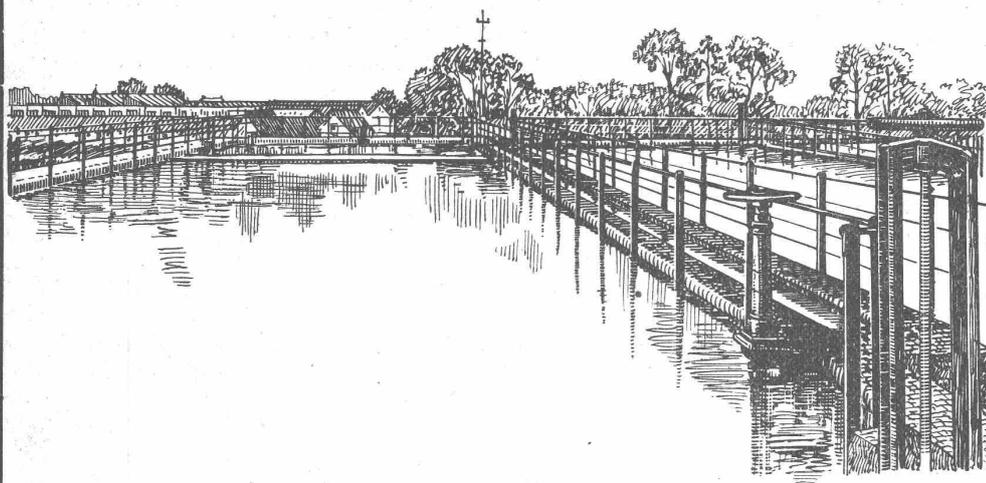
Die stark durchgerissenen und porigen hohen Sperrmauern einer alten, grossen Kläranlage in Wimbledon bei London wurden anno 1920 **während des Wasserdruckes** mit „SIKA“ gedichtet.
