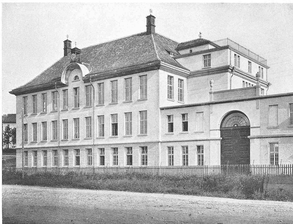
FABRIKNEUBAU HOCHULI & CIE., SAFENWIL
