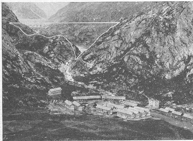
Abb. 3. Alp Emosson, Blick nach Norden auf die Staumauer-Baustelle.
