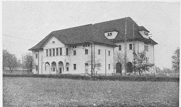
Abb. 2. Das Unterwerk Steinen im Kanton Schwyz.
