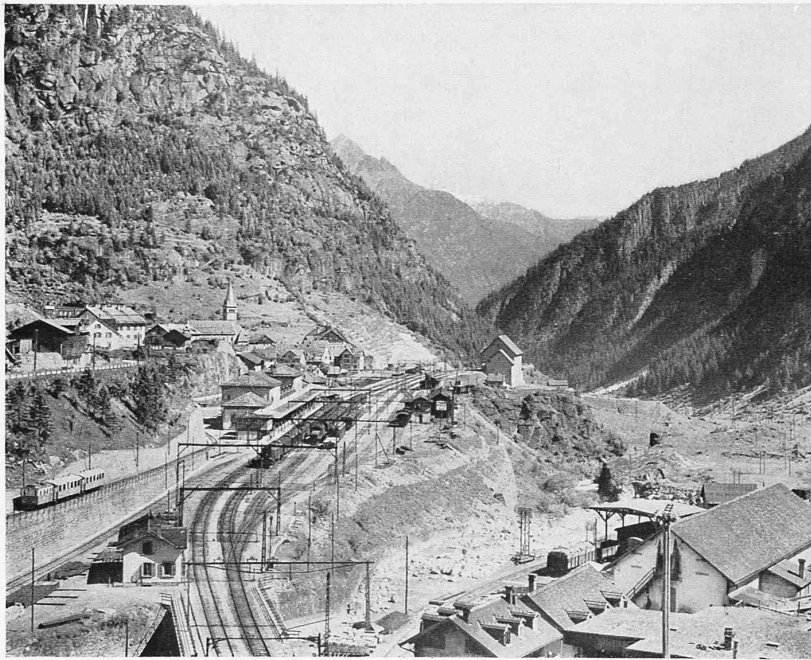
DAS UNTERWERK GÖSCHENEN
