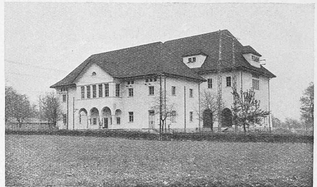
Abb. 2. Das Unterwerk Steinen im Kanton Schwyz.
