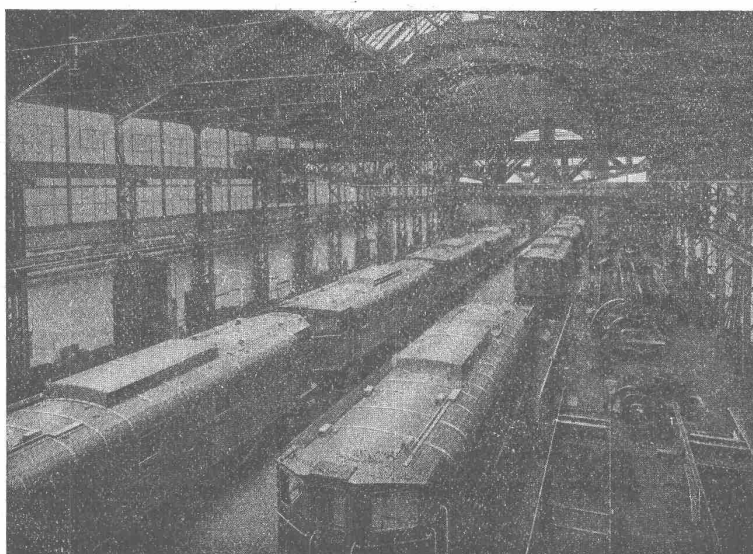
Lokomotiv-Montagehalle mit elektrischen Lokomotiven für Südafrika
