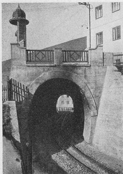
Abb. 10. Tunnel bei St. Ulrich (Grödenbahn).
