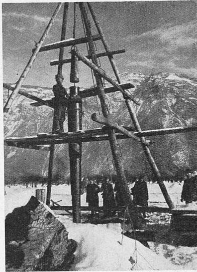
Abb. 25. Pilotierung im Gelände des Anschlussbahnhofs Auer.
