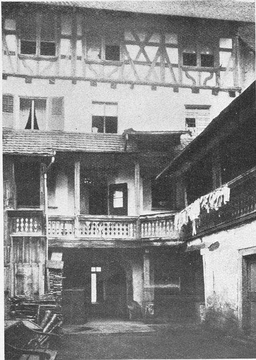
Hof des Hauses zum „Untern Sternen“ in Zurzach.
