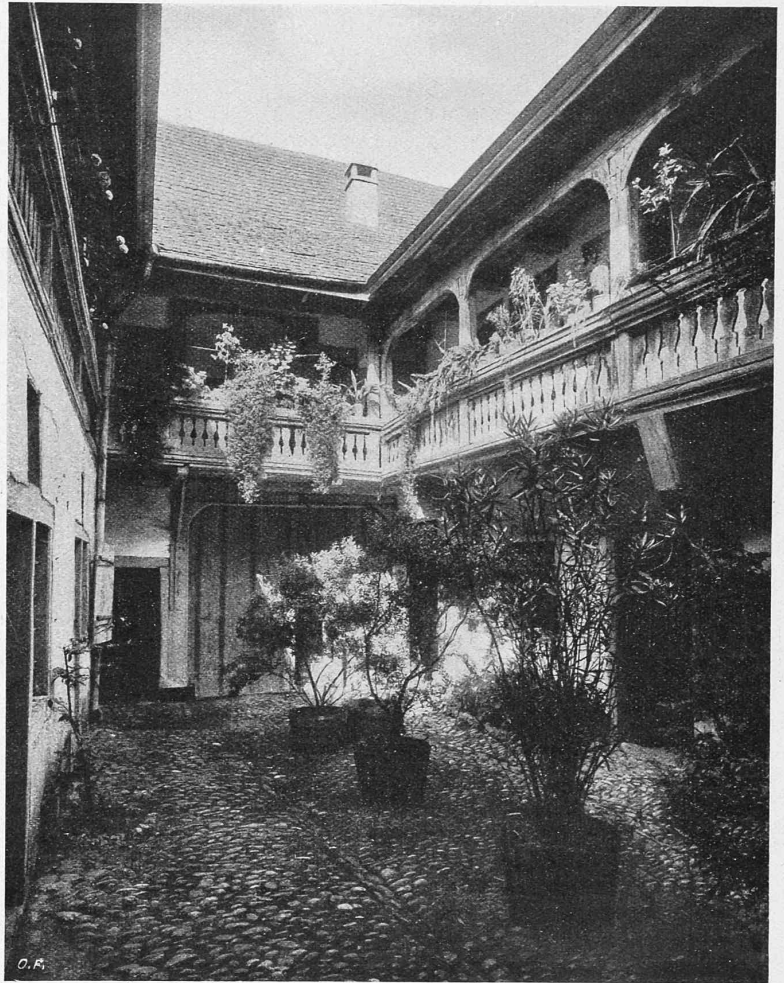
„Zum roten Hof“ in Zurzach. Ansicht des Hofes.
