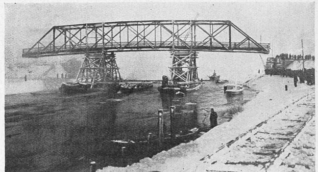
Verlegung der Mainbrücke Viereth unterhalb Bamberg.
