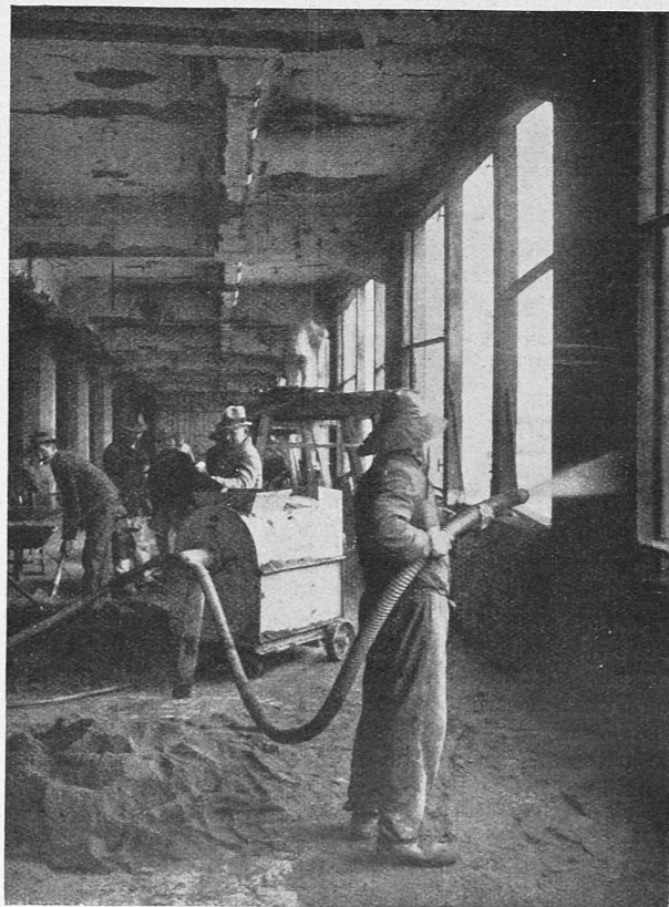
Abb. 6. Betonspritzverfahren der „Kraftbau“-Ges. Berlin
