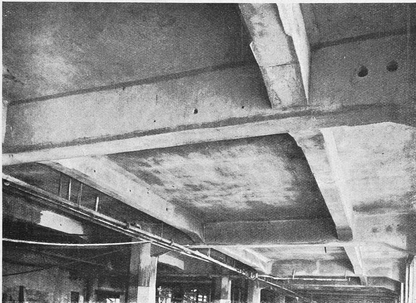
Abb. 5. Wiederhergestellte Unterzüge und Decken der Sarotti-Fabrik.
