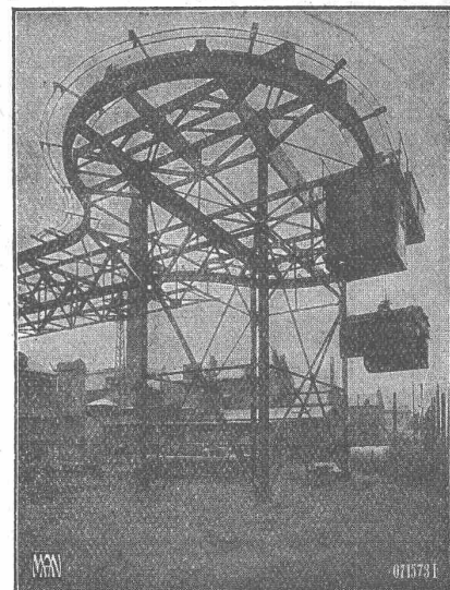
Kohlenförderanlage Kraftwerk Bingen der Kreuzbacher Elektrizitätswerke
