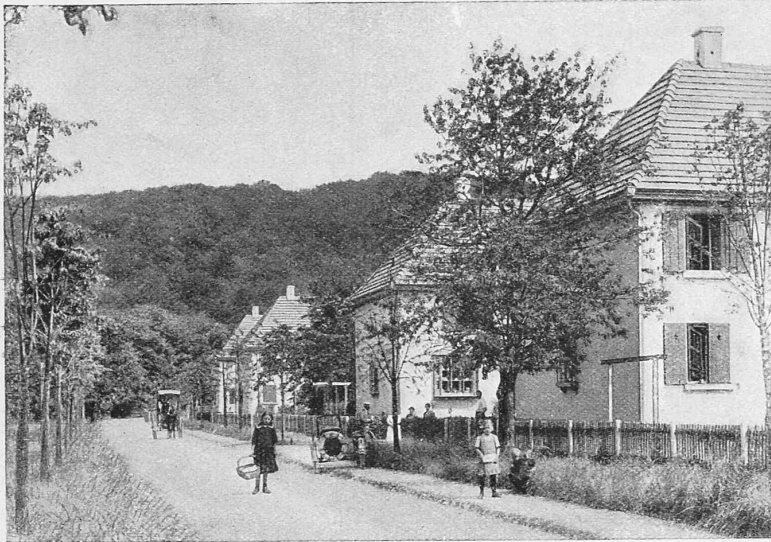
Abb. 6. Blick vom Eingang in die nördliche Querstrasse.
