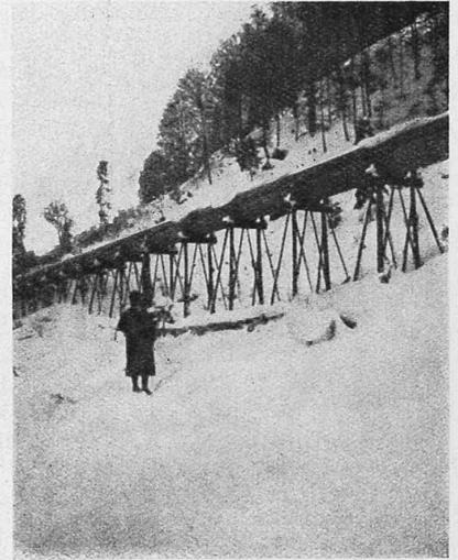
Abb. 2. Holztransportrinne in Steyring. Das Wasser wird unterwegs dreimal auch zur Kraftnutzung verwendet.
