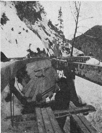
Abb. 1. Holztransport-Rinne, 1300 mm Durchm., 7200 m lang, in Steyring (Oberösterreich), in kontinuierlicher Bauweise.
