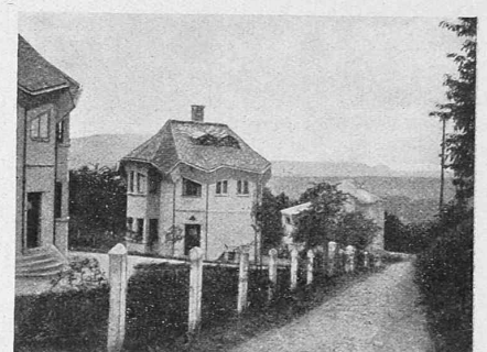
Abb. 14. Doppel-Wohnhaus u. Atelier (im Hintergrund).
