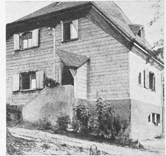
Abb. 21. Eingangspartie zu Abb. 20.
