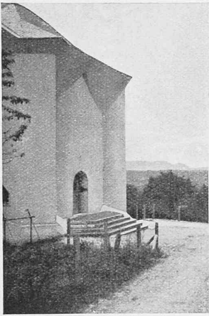
Abb. 13. Eingangspartie des Atelier.
