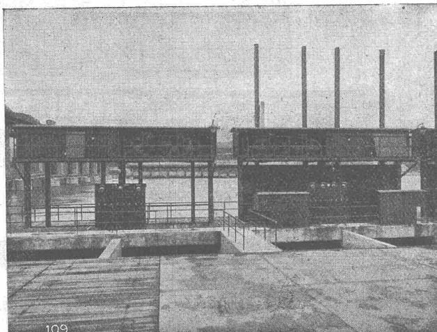
Windwerke und Turbineneinlaufschützen des Kraftwerkes Augst am Rhein.
