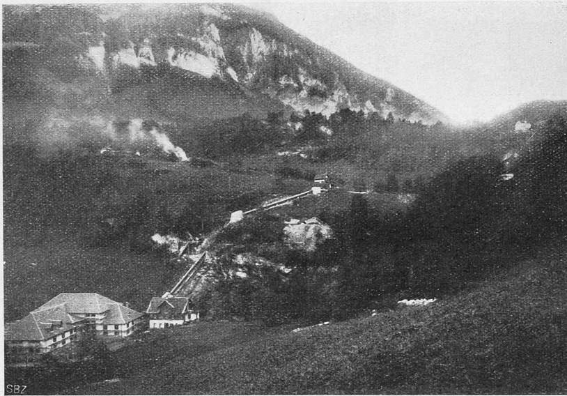
Abb. 3. Rohrleitung und Maschinenhaus des Lungernsee-Kraftwerks, oberhalb Giswil.
